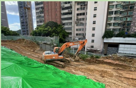
斜坡建造工程 Slope Formation Works
